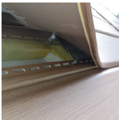
Перетянуты саморезы в финишной планке. В сайдинге саморез не докручен около 10 мм.
